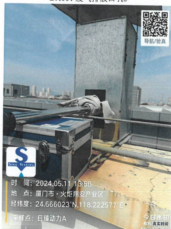
DA001 废气排放口 A#
